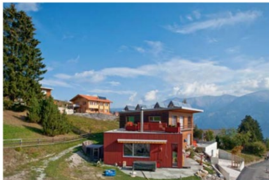
In einer dynamischen finanziellen Betrachtung sind Immobilien dann nachhaltig, wenn sie ceteris paribus mit langfristigen Entwicklungen wie steigenden Energiepreisen, demografischen Veränderungen oder Klimawandel gut umgehen können. Im Bild: EnergyPassive-Wohnzone in Flerden (GR). Bild: KeyStone
