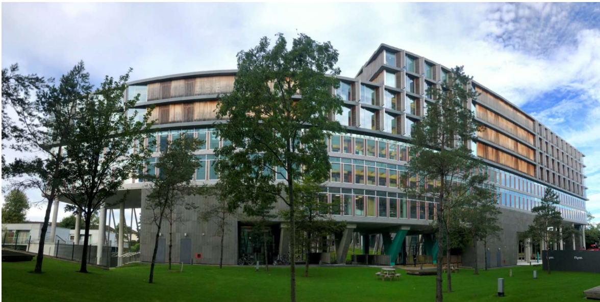
Bürogebäude «Elm Park» in Dublin
