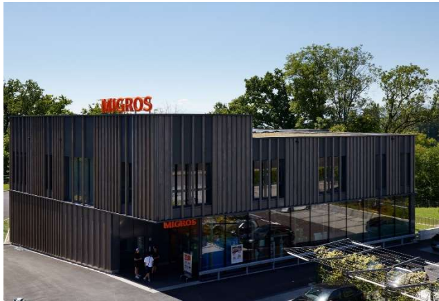
Lutry VD, Route de la Conversion 308
