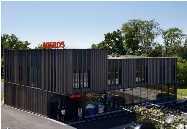
Lutry VD, Route de la Conversion 308
