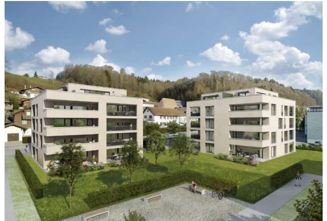
Zofingen AG, Riedtalstrasse 20b, 20d
