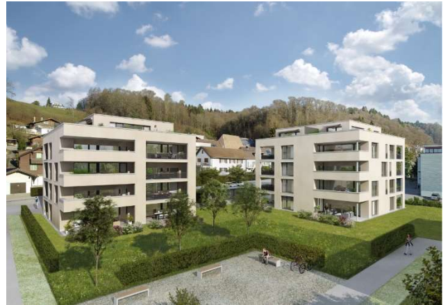
Zofingen AG, Riedtalstrasse 20b, 20d
