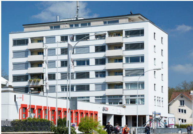
Bremgarten AG, Zürcherstrasse 15
