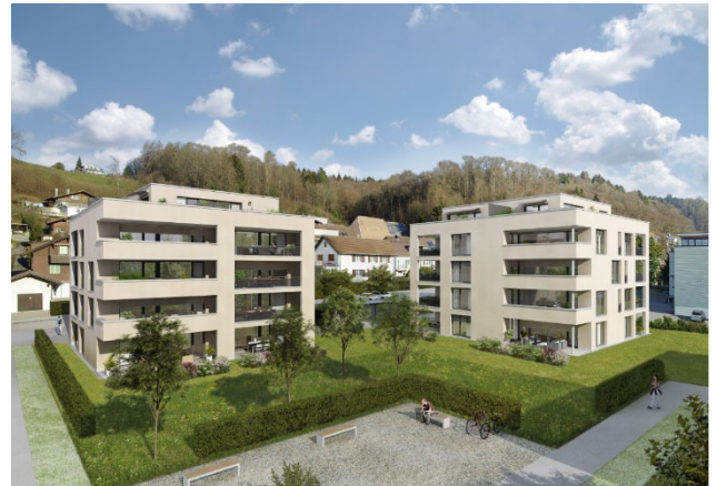
Zofingen AG, Riedtalstrasse 20b, 20d
