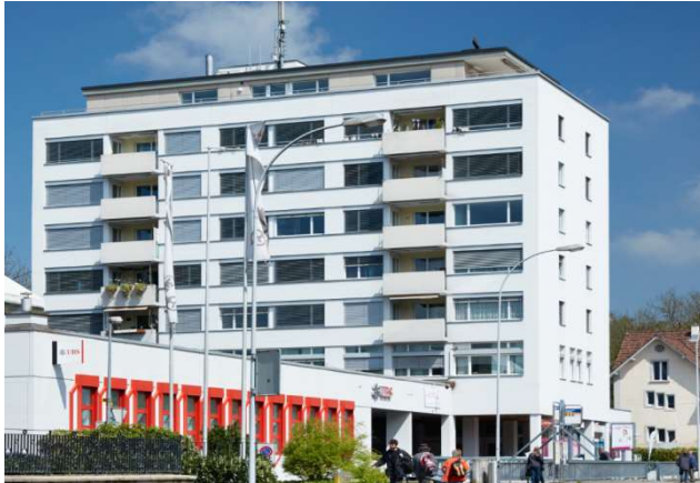
Bremgarten AG, Zürcherstrasse 15
