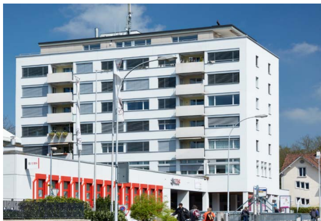
Bremgarten AG, Zürcherstrasse 15
