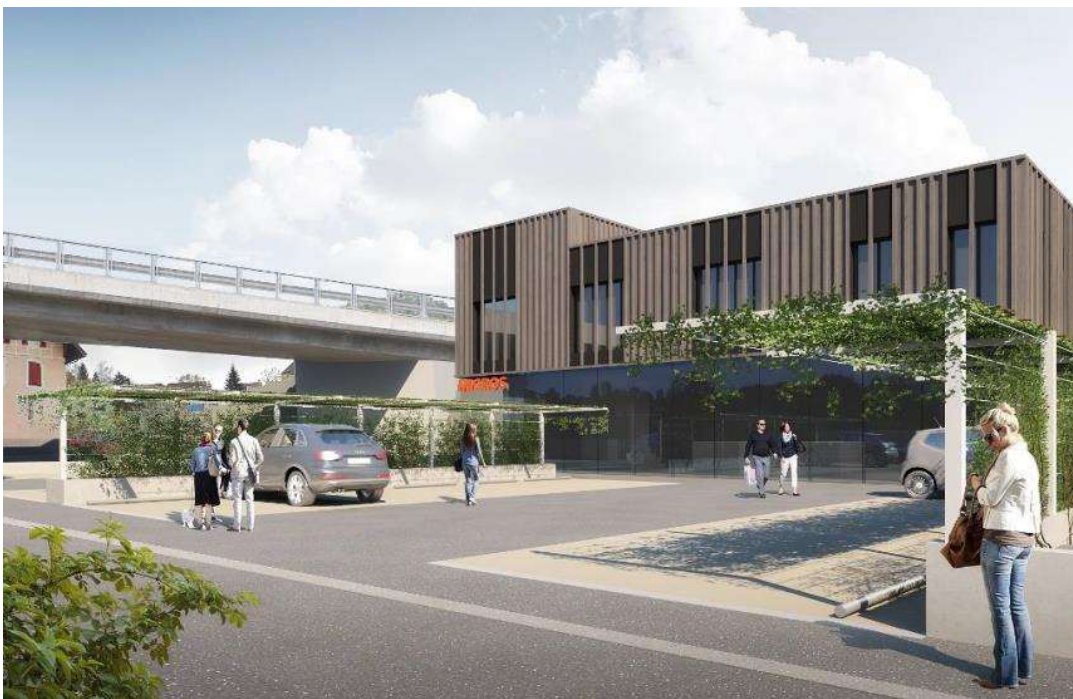
Projet de construction à Lutry (animation)
